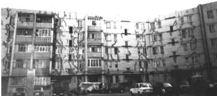
Рис. 5. Разрушение здания с плитным типом фундамента (г. Невинномысск)
