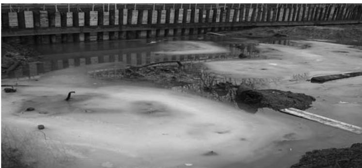
**Рис. 9. Аварийный выброс грязевого потока в строительный котлован**
