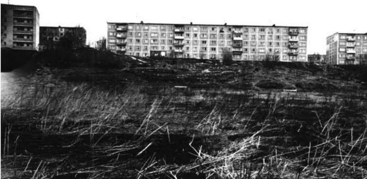
**Рис. 4. Аварийное состояние 5-этажных домов в г. Калуге, вызванное активизацией оползней на бортах крупного оврага с выпукло-ступенчатым профилем**
