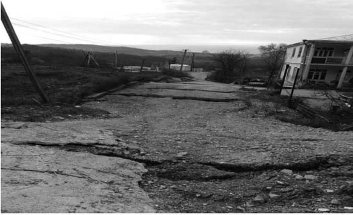
**Рис. 2. Активизация оползня незатухающей ползучести (выдавливания) в верхнеэоценовых глинах киевской свиты, разрушающий дорогу и здание; средняя крутизна склонов 3°**
