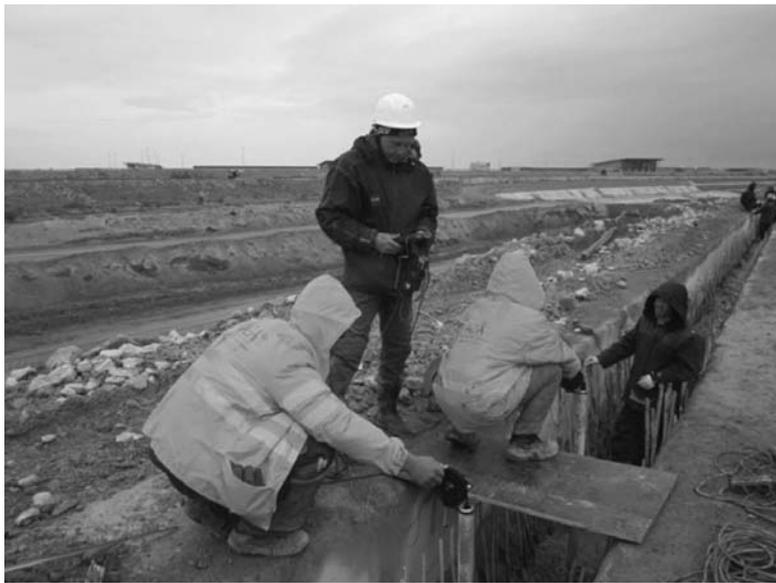
**Рис. 3. Ультразвуковое прозвучивание стыков между панелями на траншейной стене в грунте**
