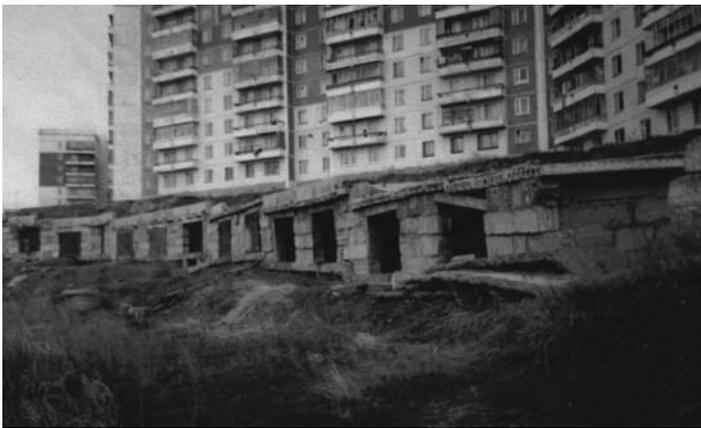
**Рис. 8. Оползень блокового типа, угрожающий разрушению 16-этажного дома в г. Железнодорожном**
