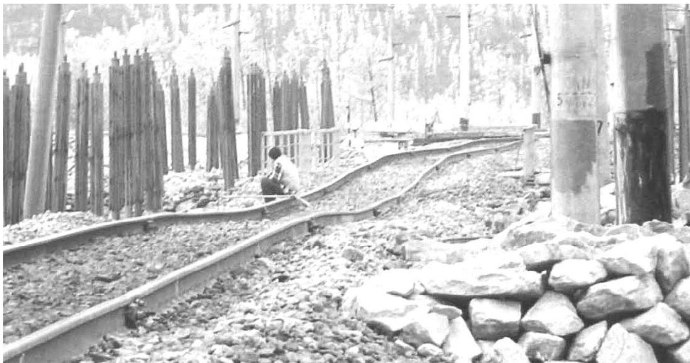
**Рис. 4.** Железнодорожный путь на участке 1373-1374 км ВСЖД в районе станции Казанкан с охлаждающей системой из каменной наброски и двух рядов вертикальных металлических труб с керосином (фото Е.А. Козыревой, сентябрь 2003 г.) [7, с. 18]
