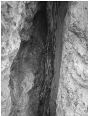
Рис. 1. Аварийный стык между панелями стены в грунте после частичной откопки котлована
