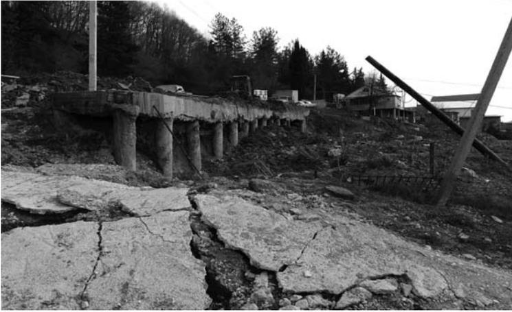
**Рис. 6. Оползень вязкопластического течения, разрушивший дорогу и нижерасположенные здания, несмотря на защитную стенку из куста буронабивных свай, в которой отсутствуют следы разрушений. Грунты оползня обтекали сваи**
