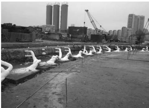
Рис. 1. Проходка эскалаторного тоннеля в заморозке
