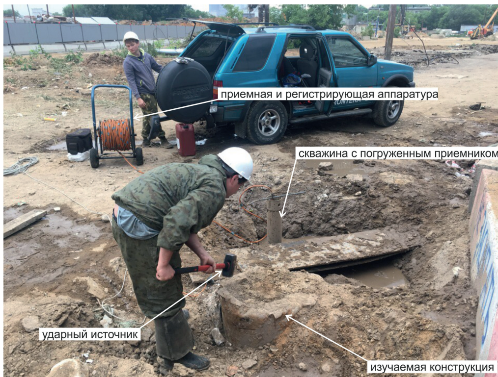
Рис. 4. Определение глубины заложения «стены в грунте» из буронабивных свай параллельным сейсмическим методом Fig. 4. Determination of secant pile wall length by parallel seismic method
