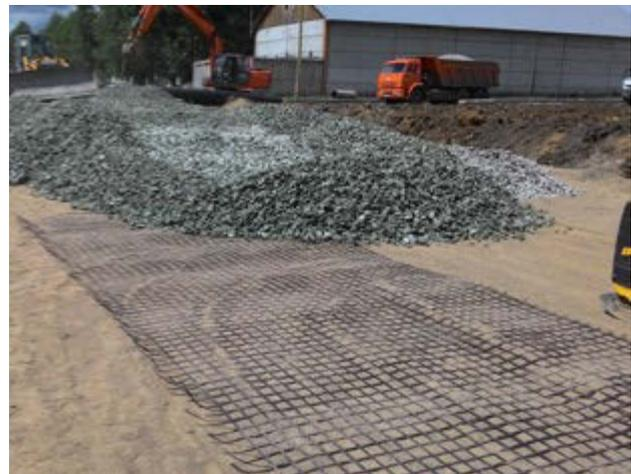
**Рис. 2. Устройство площадки с армированным песчаным слоем**
