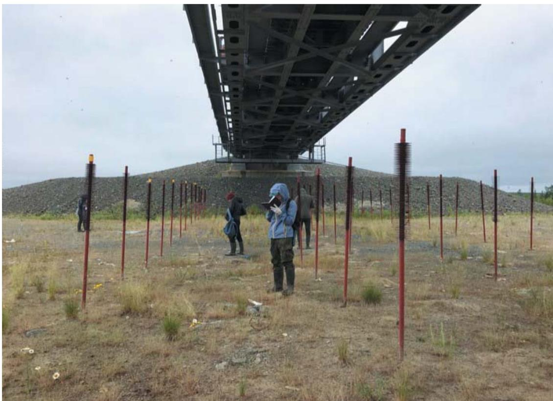
Рис. 5. Охлаждающие установки под мостом через р. Щучью (фото Комовой Н.Н.)
