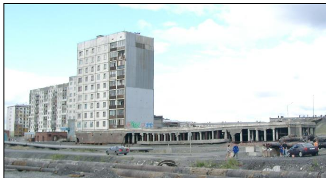
Рис.6. Норильск. Деформированный криогенными процессами фундамент разобранных секций 9-этажного здания (фото Д.С.Дроздова)
