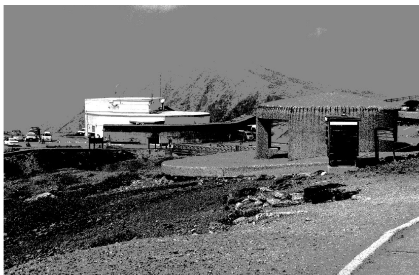
Рис. 3. Бетонированные укрытия от вулканических бомб на смотровой площадке кратера Накадаке вулкана Асо (фото автора).
