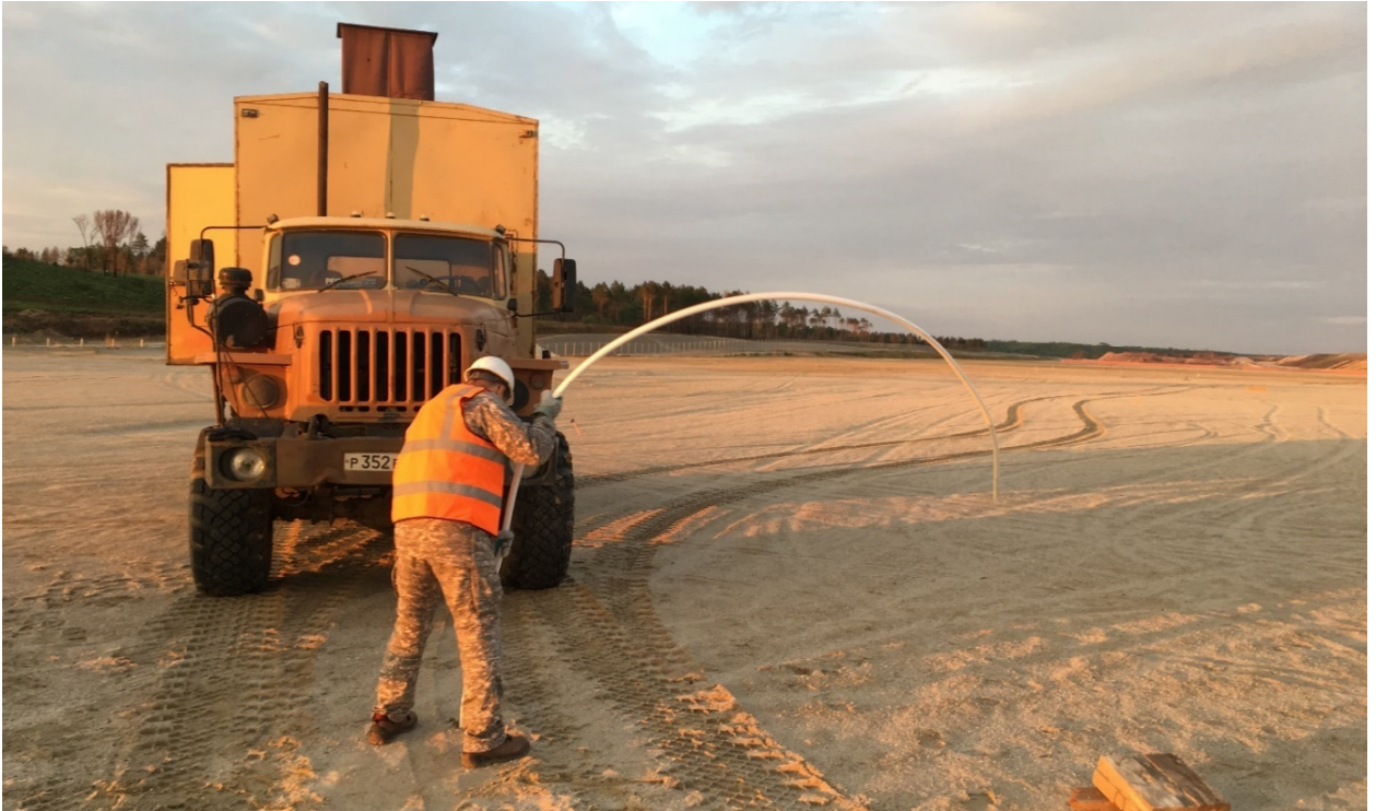
Рисунок 35 — Этапы установки обсадной трубы в термометрическую скважину, 3-я минута (фото автора)
