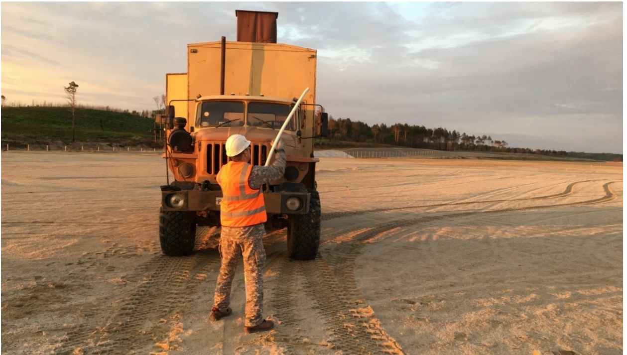
Рисунок 36 — Этапы установки обсадной трубы в термометрическую скважину, 5-я минута (фото автора)
