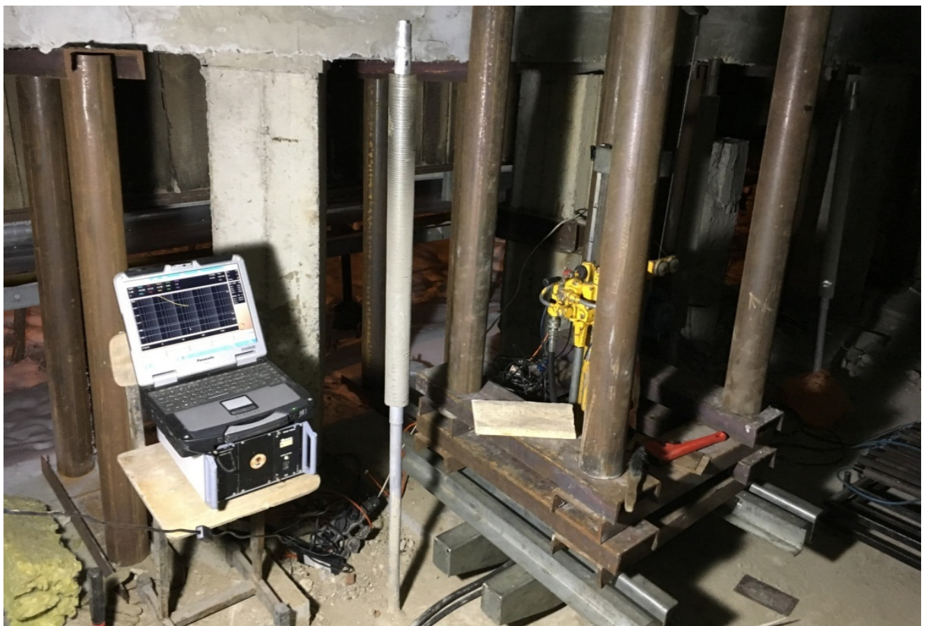
Рисунок 69 — Мобильная установка статического зондирования во время испытания ТСРТ-04 (фото автора)
