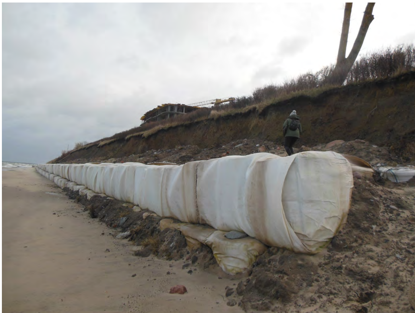
Рисунок 2. Берегоукрепительные «биг-бэги» в западной части г. Зеленоградск
