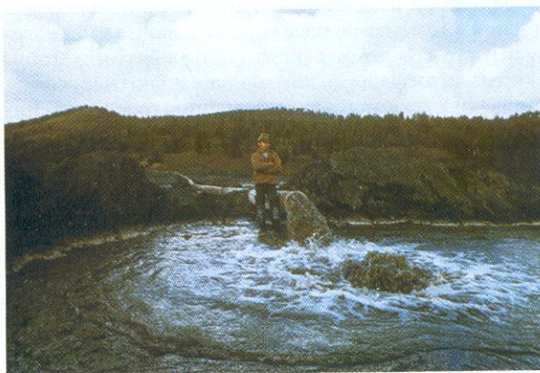
Рис. 4. Намыв золы из пульпопровода с образованием искусственного озера и осадков зола уноса (фото Е.Н. Огородниковой).
