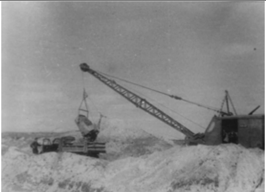
**Фото 7. Разведочные работы шурфованием**
