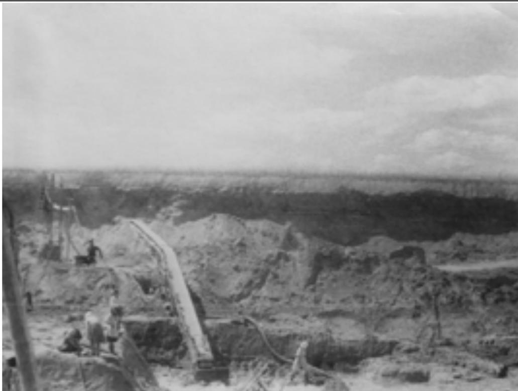
**Фото 9. Проходка карьеров с применением отгрузочных средств, видна дорожка для вагонеток с породой, выгружаемой в терриконы.**
