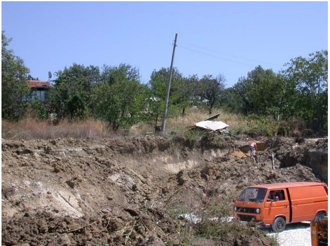
Фиг. 2. Свлачище и хлъзгателна повърхност в обект “Пчелина”.
